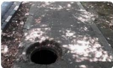
Kanalizaciona mreža bez poklopca u saobraćajnom putu [3]
