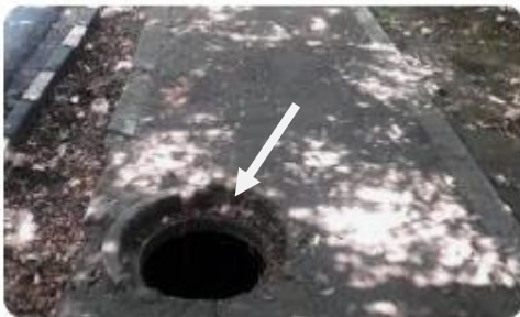
Rrjeti i kanalizimit pa kapak në rrugën qarkulluese [3]
